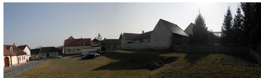
fotografie, současný stav
